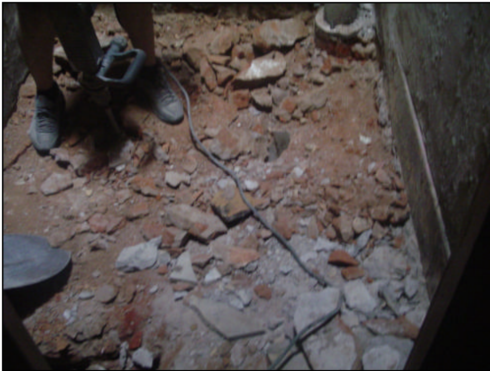
Foto 1: Inici del treball constructiu.
