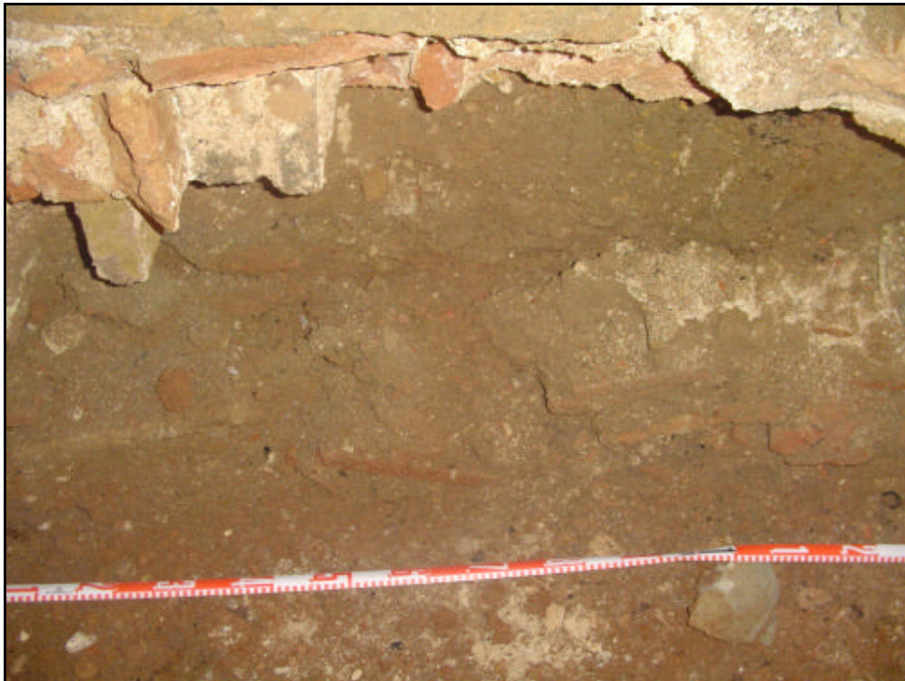
Foto 3: Imatge de detall de les fonamentacions de les parets de l'edifici un cop rebaixat el fossat per a l'ascensor.
