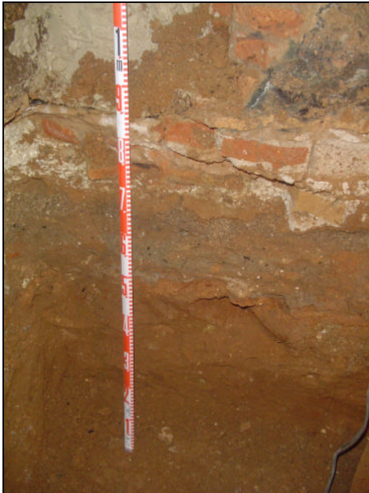
Foto 2: Detall del fossat d'ascensor al carrer Ramelleres núm 16-20.
